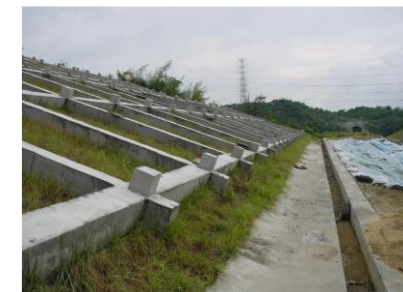
土釘及格梁護坡
