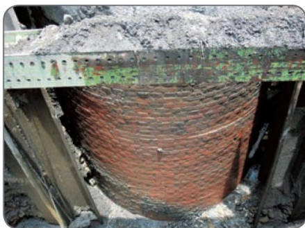
磚砌沉箱出露情形
