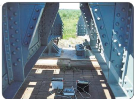
監測儀器設置
